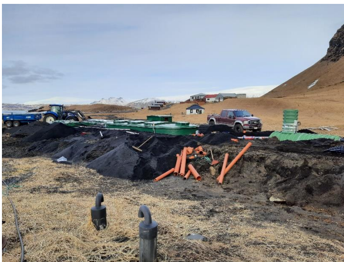
MYND 14 FRAMKVÆMDIR Í GANGI Á SUÐURLANDI VIÐ FRÁGANG HREINSISTÖÐVAR
